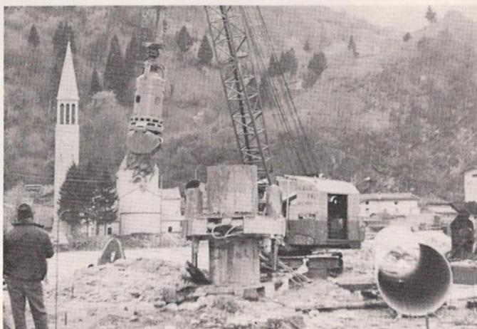
Stanno scendendo i tubi d'acciaio che danno forma ai pali di sostegno del nuovo ponte ferroviario.
